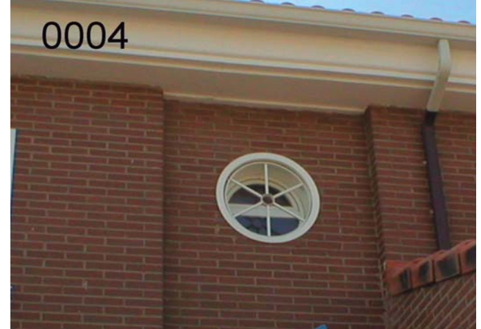
RE-0004: Reja "ojo de buey", modelo simple de barrotes radiales de cuadradillo de 16*16 mm., aro central decorativo de pletina, imprimacion "wash primer" y lacado al horno blanco.
