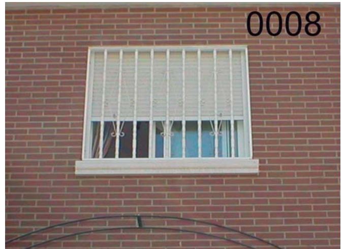
RE-0008: Reja fija de tubo ornamental, barrotes de diam. 25-30 mm., con detalles decorativos en "S" alternos de pletina, imprimacion "wash primer" y lacado al horno blanco.
