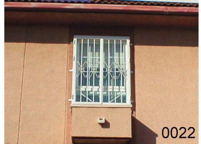
RE-0022: Reja abatible 2 hojas con cerradura, modelo de acero macizo, barrotes de cuadradillo 16*16 mm., con detalles decorativos en forma de "S", imprimacion "wash primer" y lacado al horno blanco.
