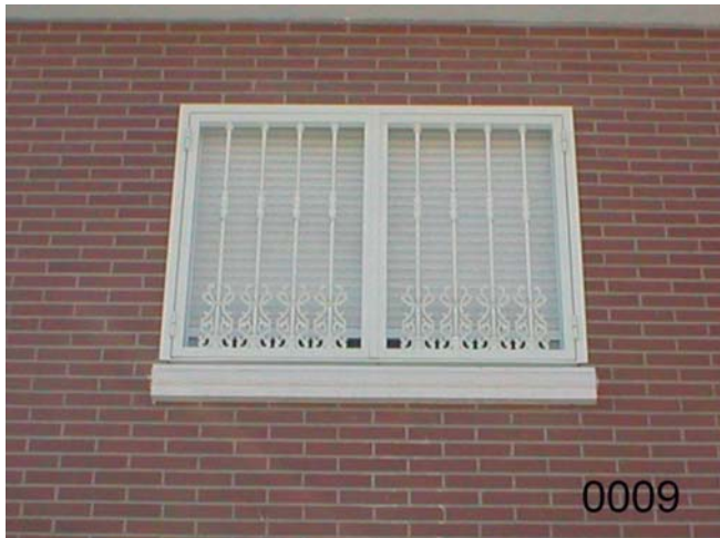
RE-0009: Reja abatible 2 hojas con cerradura, modelo de barrotes de macizo de diam. 16 mm., detalles inferiores decorativos, macollas de fundido, imprimacion "wash primer" y lacado al horno blanco.
