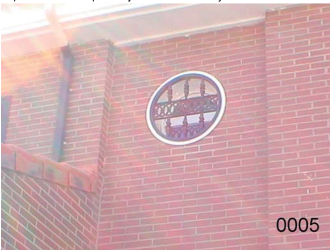
RE-0005: Reja "ojo de buey", modelo de barrotes de cuadradillo de 16*16 mm., aro con macollas y solera decorativos, imprimacion "wash primer" y lacado al horno oxirón gris.
