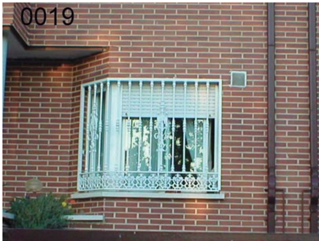
RE-0019: Reja de mirador fija de acero macizo, barrotes de diam. 16 mm., con macollas y dibujo central de fundido, solera inferior decorativa de fundido, imprimacion "wash primer" y lacado al horno blanco.
