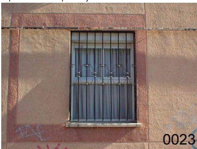
RE-0023: Reja fija modelo de acero macizo, barrotes de cuadradillo 16*16 mm., con detalles decorativos en forma de "S", imprimacion "wash primer" y lacado al horno blanco.
