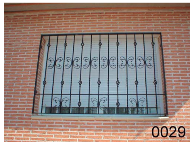
RE-0029: Reja fija modelo de acero macizo, barrotes de cuadradillo 16*16 mm. con piñas, detalles decorativos en forma de "S", imprimacion "wash primer" y lacado al horno negro.
