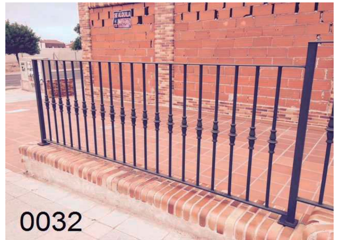
BB-0032: Barandillas de acero macizo, barrotos de diam. 16 mm., con macollas centrales, pilastras de 40*40 mm., pasamanos superior y bastidor inferior de pletina de 40*8 mm., imprimacion "wash primer" y lacado al horno negro.
