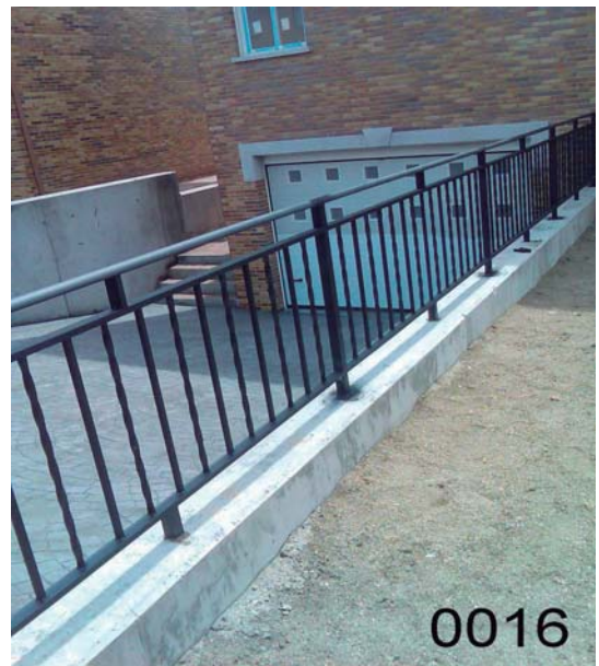
BB-0016: Barandilla mixta, barrotes de macizo de 16*16 mm. con rizados salomonicos alternos, pilastras de 40*40 mm., horizontales de 40*20 mm., pasamanos media caña 50*25 mm., imprimacion "wash primer" y lacado al horno negro.
