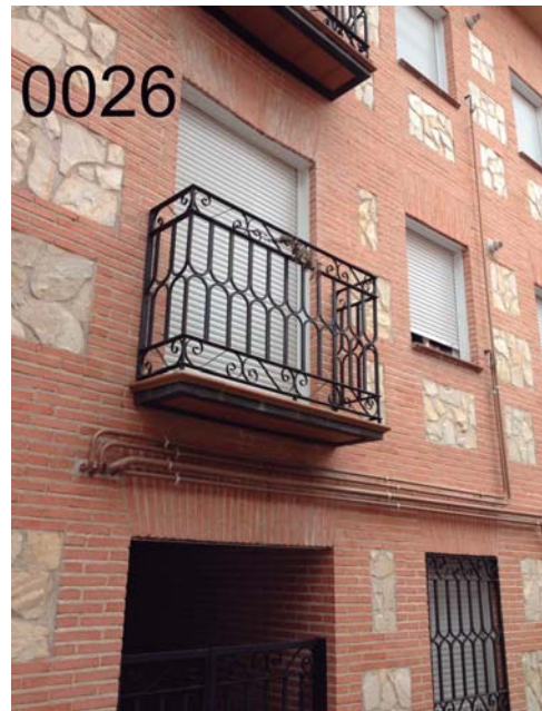
BB-0026: Balcón de acero macizo, barrotes de cuadradillo 14*14 mm., con formas medio punto, detalles decorativos en forma de "S" superior e inferior pasamanos, imprimacion "wash primer" y lacado al horno oxirón gris.
