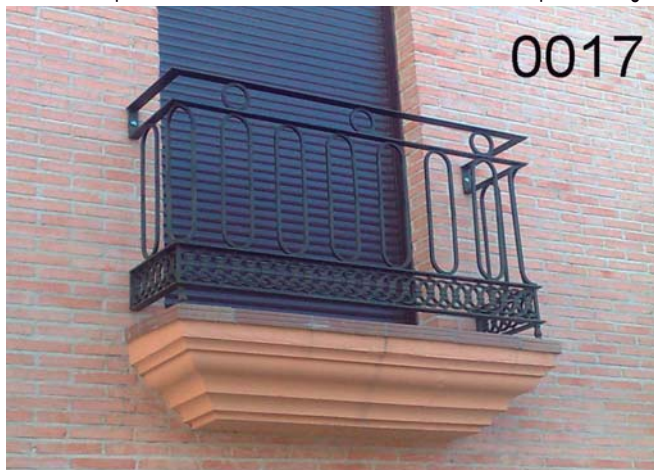
BB-0017: Balcón de acero macizo, barrotes de cuadradillo 14*14 mm., con formas medio punto, aros de cuadradillo de 14*14 mm., solera de aros decorativa, pasamanos, imprimacion "wash primer" y lacado al horno oxirón gris.
