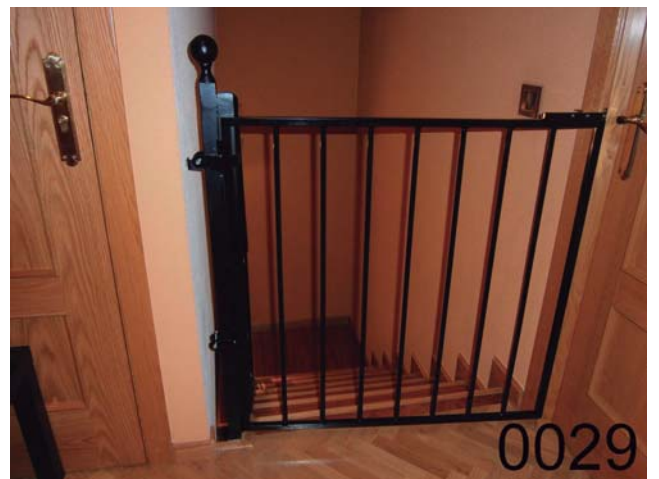
BB-0028-0029: Barandilla-barrera de escalera para niños, sin cerco inferior, con barrotes de tubo de 16 mm., con hoja de tubo de 20*20 mm., pestillo a cerco de madera de puertas, sujeto a barandilla de escalera, imprimacion "wash primer" y lacado al horno negro.
