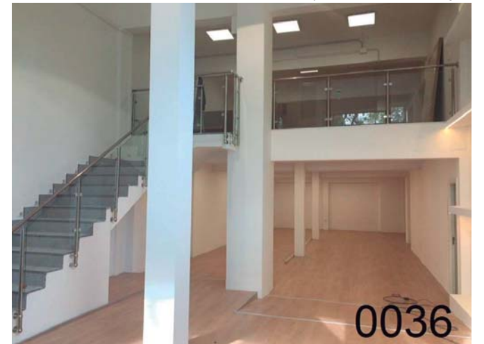
BB-0036: Tiro escalera y barandillas de acero inoxidable modular y lunas laminares, pilastras, pinzas y pasamanos, montaje lateral con plafones y escudos, acabado pulido brillo
