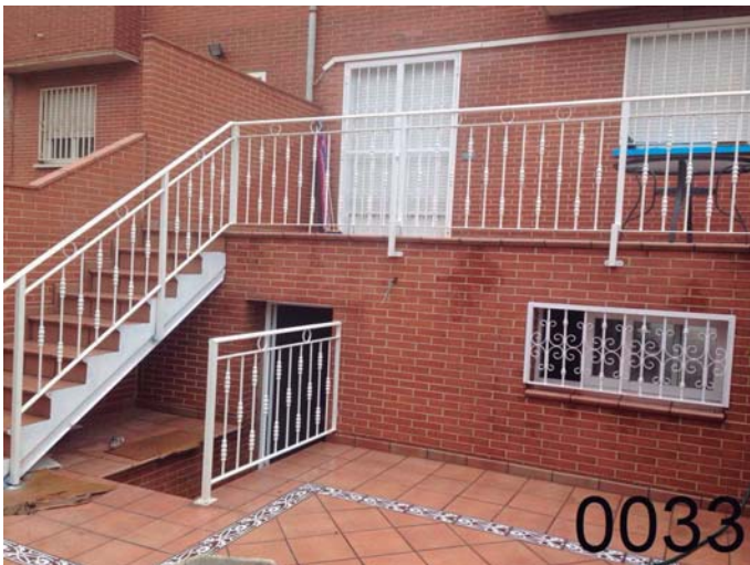
BB-0033: Tiro escalera y barandillas mixto, barrotos de diam. 16 mm., con macollas centrales, aro, pilastras de 40*40 mm., horizontales de 40*20 mm., pasamanos media caña 50*25 mm., imprimacion "wash primer" y lacado al horno blanco.
