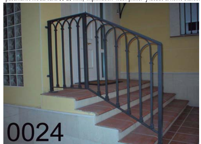
BB-0024: Tiro escalera y barandilla de acero macizo, barrotes de cuadradillo de 20*20 mm., con macollas base y anillo, arcos superiores con interseccion de 20*10 mm., pilastras, pasamanos, imprimacion "wash primer" y lacado al horno oxirón gris.
