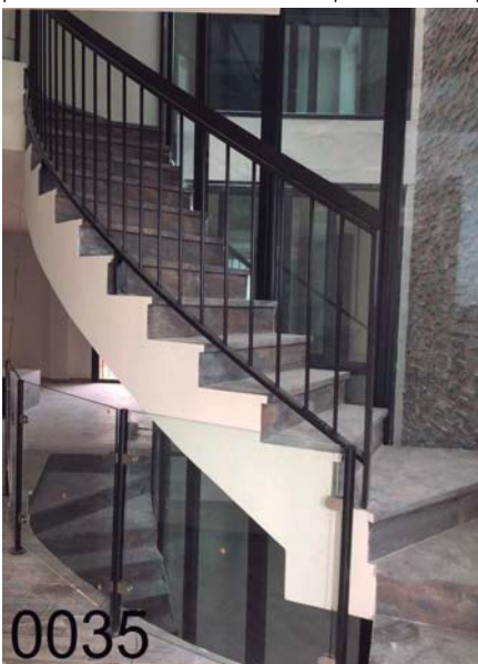
BB-0033: Tiro escalera y barandillas mixto, barrotos de diam. 16 mm., con macollas centrales, aro, pilastras de 40*40 mm., horizontales de 40*20 mm., pasamanos media caña 50*25 mm., imprimacion "wash primer" y lacado al horno blanco.
