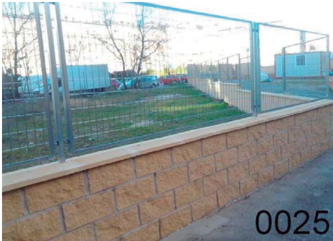
BB-0025: Valla de malla electrosoldada 50x100x4 mm., cerco de tubo de 35*15 mm., postes de tubo de 40*40 mm., acabado cincado en frío.
