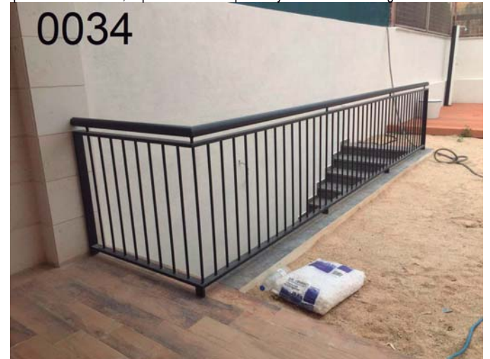
BB-0034: Barandilla mixta, barrotos de macizo de diam. 16 mm, pilastras y bastidores horizontales de 50*20 mm., pasamanos de diam. 50 mm., imprimacion "wash primer" y lacado al horno negro.
