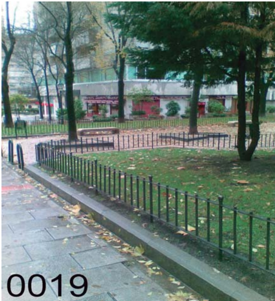
BB-0019: Barandilla de jardín de acero macizo, barrotes de diam. 16 mm., pasantes a pletinas macizas superior e inferior de 30*8 mm., pilastras de diam. 20 mm., con bola superior, imprimacion "wash primer" y lacado al horno oxirón gris.
