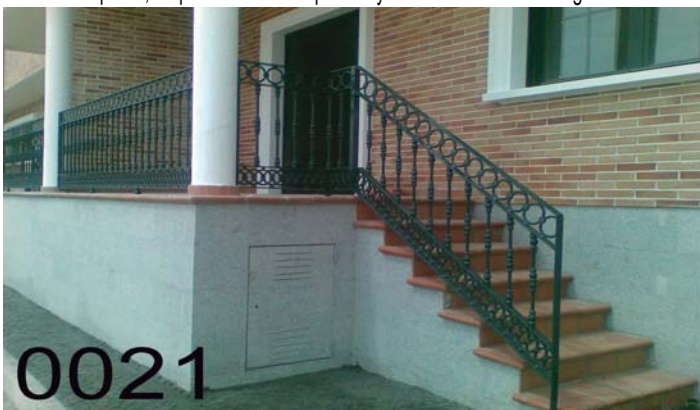
BB-0021: Tiro escalera y barandillas de acero macizo, barrotes de diam. 16 mm., con macollas centrales y bases de fundido, solera decorativa superior e inferior, pilastras, pasamanos, imprimacion "wash primer" y lacado al horno oxirón gris.
