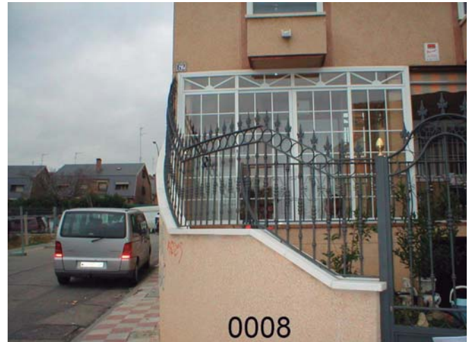
BB-0008: Barandilla valla curva y ascendente, acero macizo, barros de diam.16 mm.,macollas centrales y anillos de fundido, aros decorativos de pletina, puntasde lanza, imprimacion "wash primer" y lacado al horno oxirón gris.
