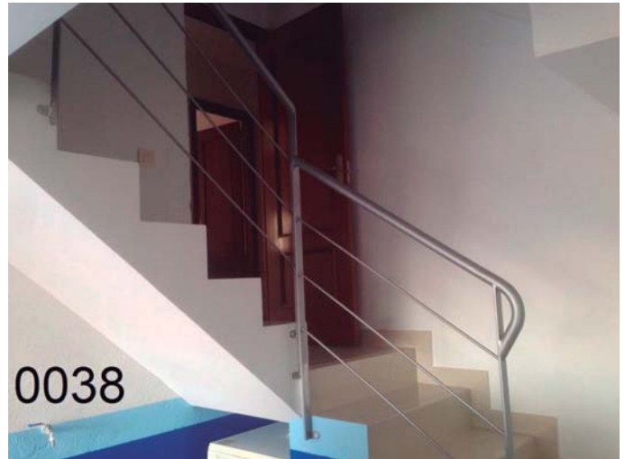
BB-0038: Tiro de escalera de varillas horizontales de diam. 12 mm., verticales de pletina de 40*8 mm., pasamanos de diam. 40 mm., imprimacion "wash primer" y lacado al horno gris plata metalizado RAL 9006.
